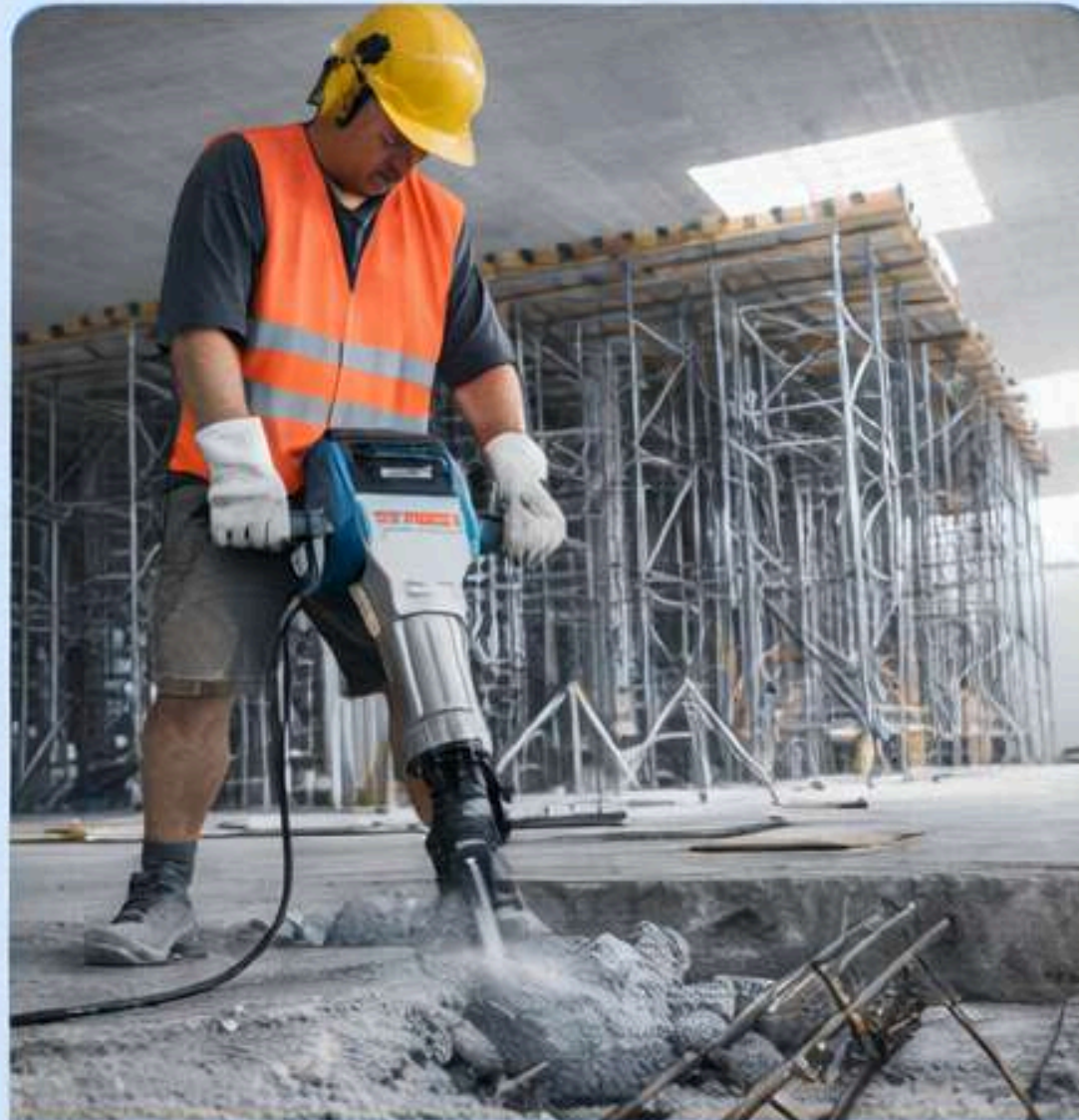
DEMOLEDORES DE CONCRETO
